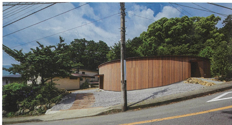
北東側外観。外壁は幅105mmのセラガンバツを張った。
