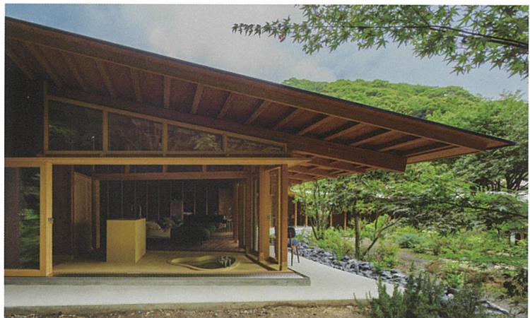
浴室外観。浴槽は床から掘り下げてつくった。軒高は4,903mm。
